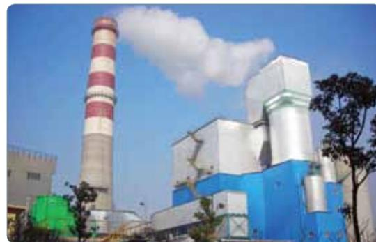
采用干法——循环流化床脱硫技术的梅钢4#烧结机烟气脱硫装置于2009年7月底投入试运行，脱硫效率≥90%，可削减SO<sub>2</sub>排放量约6000吨/年。
