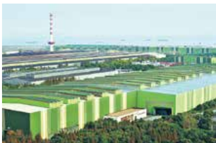
宝钢“金太阳光伏示范工程”项目
