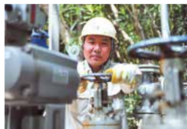
宝钢化工公司员工在现场进行蒸汽冷凝水回收作业
