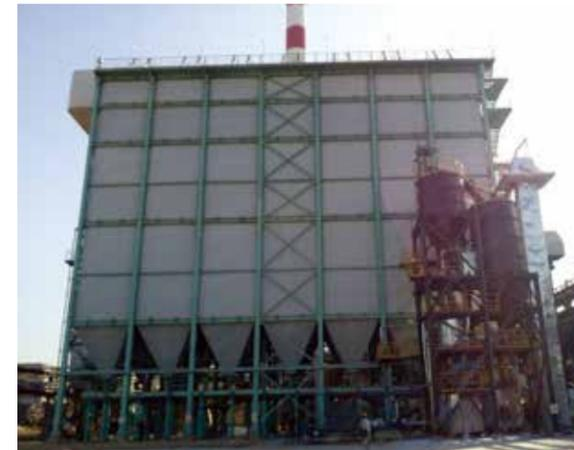
湛江钢铁烧结烟气净化装置于2015年12月初进行系统调试，脱硫、脱硝系统运行基本稳定。
