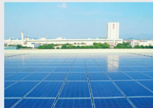
宁波市北仑光伏发电项目为宝钢节能首个自主集成的EMC（合同能源管理）项目，主要为宁波宝新、宁波钢铁两家钢企部分厂房屋顶加装光伏发电设备。项目装机容量为20兆瓦，预计年平均发电量为1866万千瓦时，可节约6232吨标煤，减少CO<sub>2</sub>排放近14957吨。
