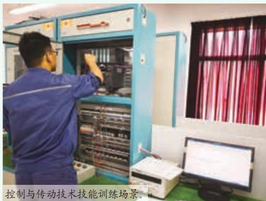
设备点检员在点检生产设备。
