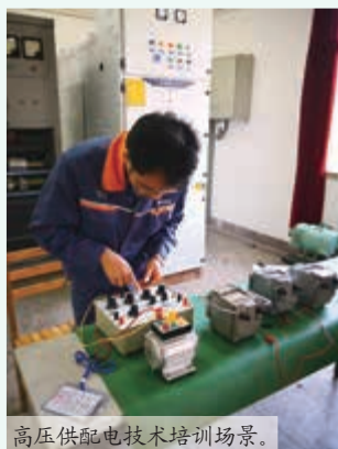
高压供电技术培训场景。
