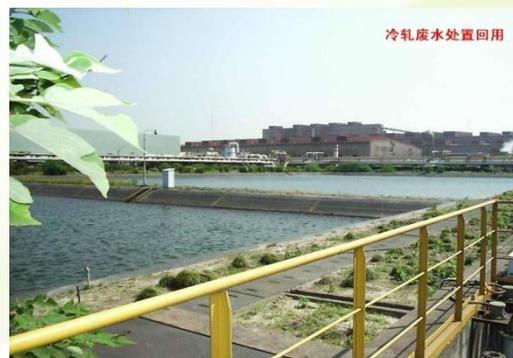
节能减排，环境治理，打造绿色钢铁企业，新环保装备必不可少。从原料输入到生产线，从生产线到成品输出，每道工序都直接或间接的体现着环保技术的升级和环保装备的领先。30万吨级散货码头增设船用岸电系统，大大减少船舶靠泊期间利用辅机发电产生的大量废气；球团所有皮带通廊封闭、石灰单元全部气力输送，减少中转产生二次污染；原料粉状物料及煤仓储采用全封闭模式，消除全厂最大无组织排放；烧结、电厂全面实施脱硫脱硝，最大限度推进清洁生产水平；人工湿地、焦化冷轧废水冲渣及深度处理技术的运用，实现外排废水减量化，并为进一步实现废水零排放提供良好基础。
